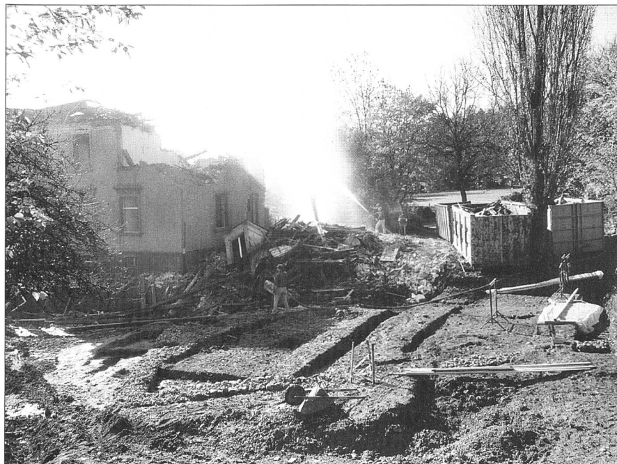
Abb. 4 Olten/Feigelhof. Blick auf die Ausgrabungen während des Abbruchs der Villa – nicht der römischen, sondern derjenigen von 1925.
