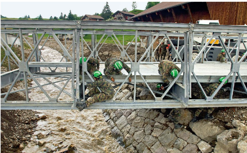
Genietruppen beim Brückenbau.
