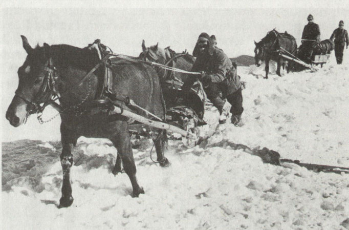
Der gebrochene und gefestigte Ruttnerpfad wird mit Schlitten transportiert, deren Kufen man quer mit einer Kette verbindet.
