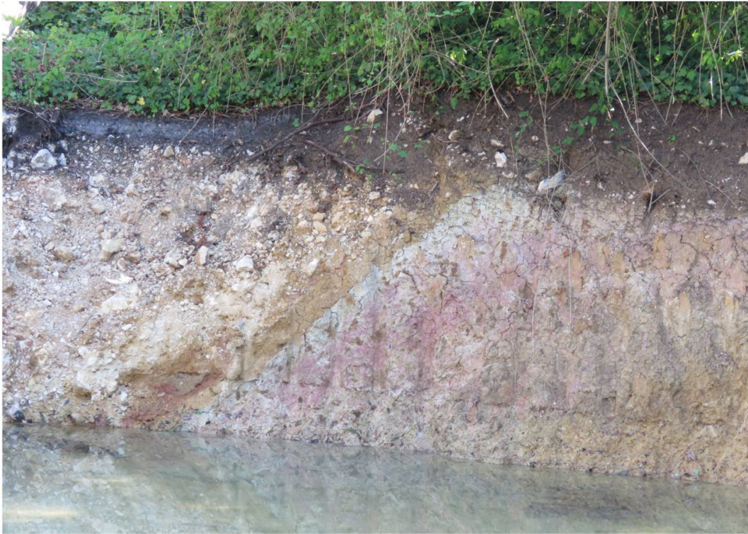
Fig. 4: Paquet glissé de calcaires très fracturés (nord-ouest, à gauche sur la photographie) reposant sur la molasse faciès Terre jaune (à droite); noter le contact à pendage incliné vers le nord-ouest. La hauteur de l'affleurement est d'environ 1 m. Été 2016, fouille à l'extrémité est de la route du Domont (coordonnées 592 530/246 090).
