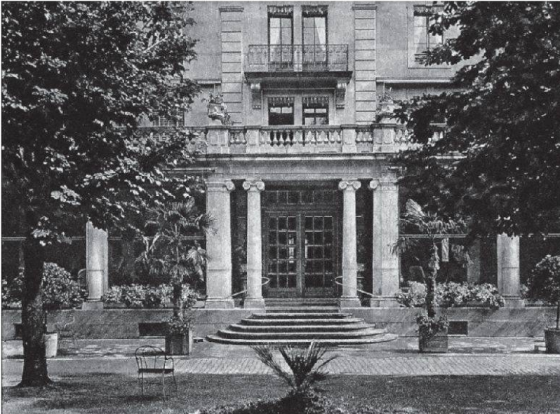
12 Haupteingang des Hotels auf der Südseite (Foto: Stadtarchiv Baden, Q.11.1.17).
