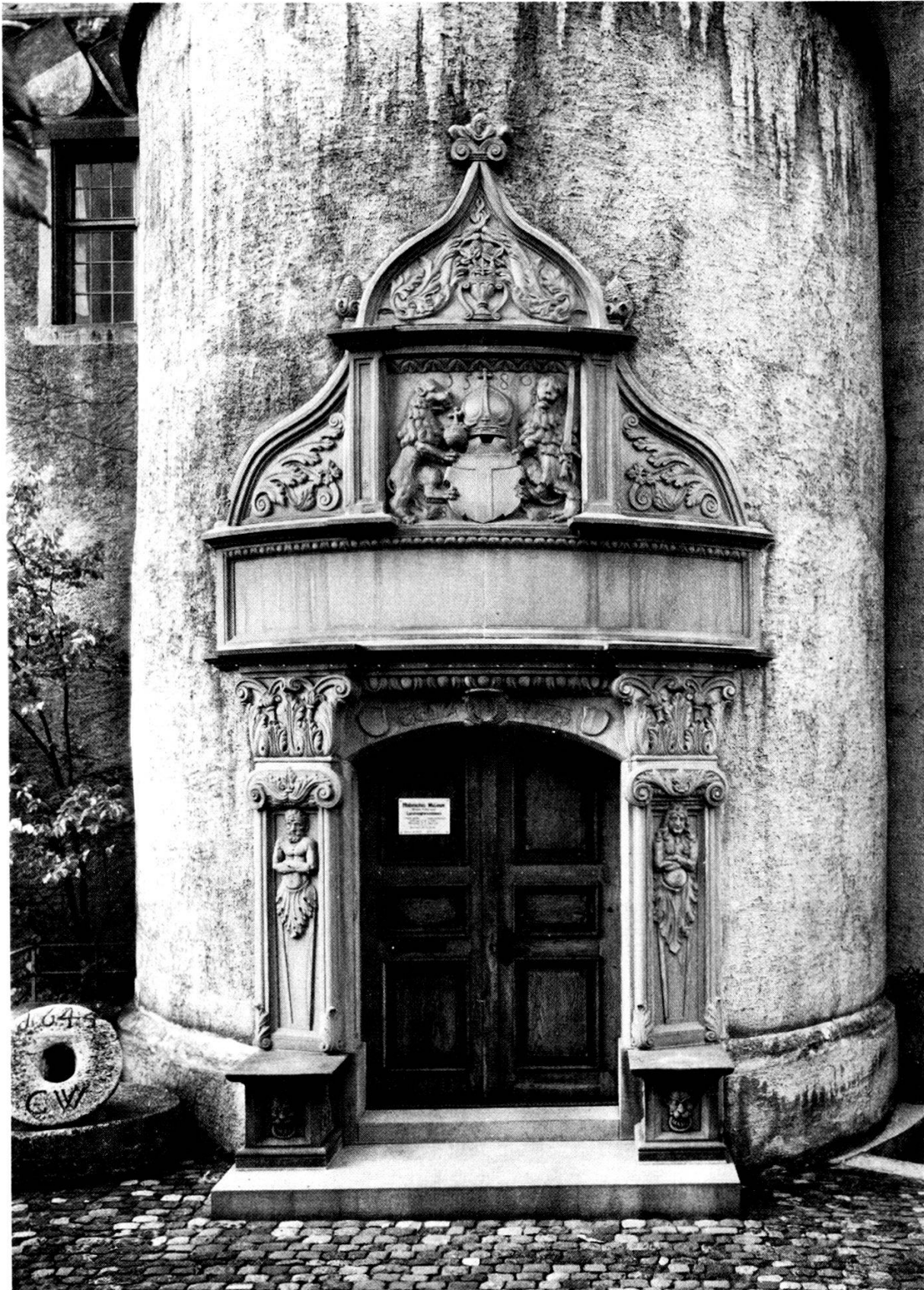
Das renovierte Portal des Landvogteischlosses Baden, 1580
