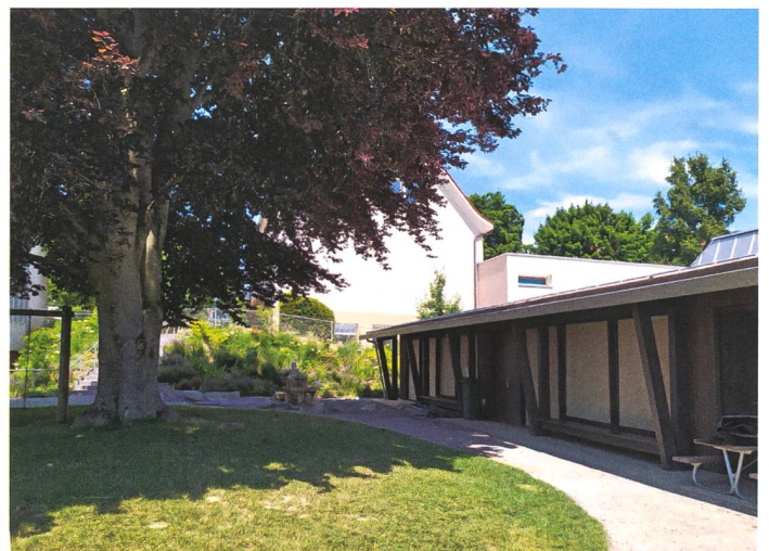
Neubau Doppelkindergarten Sulgen TG, Fertigstellung im Herbst 2017. / Double jardin d'enfants à Sulgen (TG), fini à l'automne 2017.
