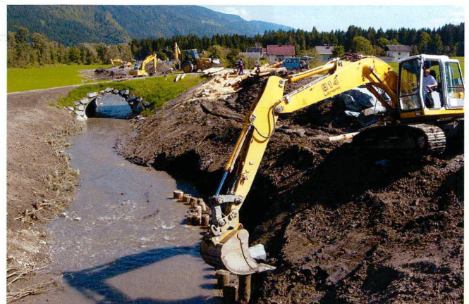
4 Mit Holzpiloten und ingenieurbioologischen Bauweisen wurde an der Dammaussenseite wieder ein strukturreiches Fließgewässer hergestellt. Par le biais du génie biologique et des pilotis en bois, un ruisseau riche en structures a pu être recréé. D. Koller
