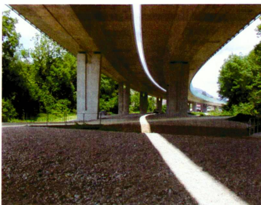
Anlage unter dem Viadukt Chanélaz.
