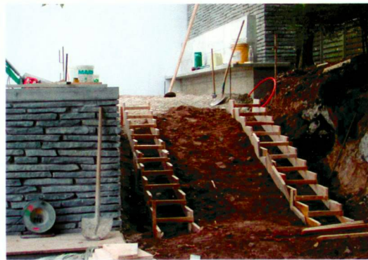
Unterbau der Treppe.
