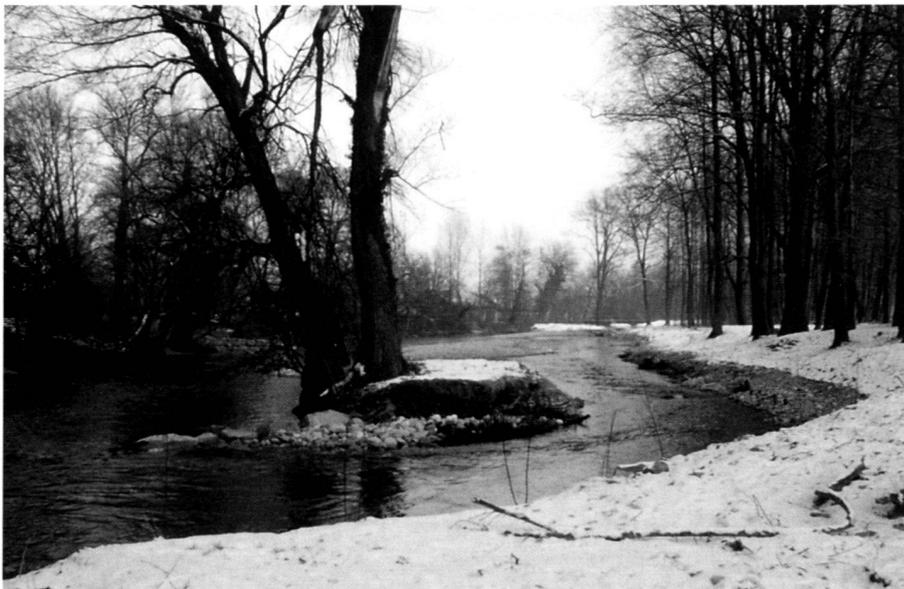
blocs erratiques. Trois épis à ailes triangulaires formés de lits de plançons servent à régler le niveau d'eau du nouveau bras, aussi en cas d'eaux basses. Pour améliorer les structures d'écoulement, on a construit d'autres parapets de fascines. Dans les zones de rive, des arbres disposés en épi et de grandes rhizomes accroissent la diversité.
