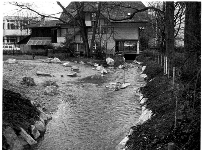
Création de nouveaux espaces de vie et de nouvelles possibilités de jeux: «il est autorisé de jouer le long du Stadtbach» ( à gauche: avant, à droite: après ).
