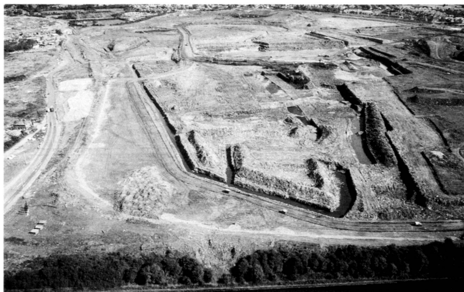
Geländeschüttung, Flugaufnahme 1985. Remblai de terrain, vue aérienne 1985. – Aerial progress shot 1985.
