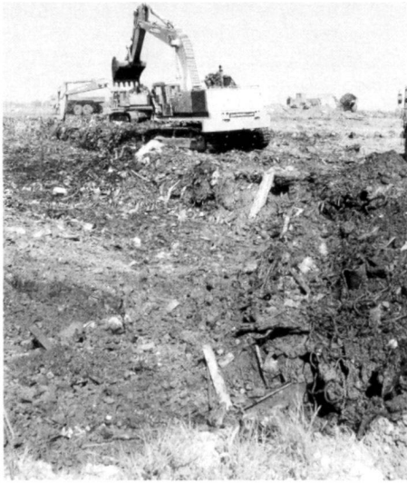
Links: Geländemodellierung mit Abfallmaterial.
