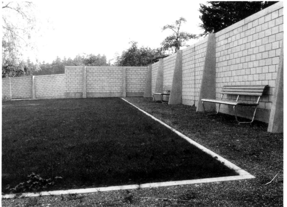
Neue Mauer mit Grabfeld. Foto: F. Bochud, Zürich Nouveau mur avec champ de tombes. New wall with grave area.
