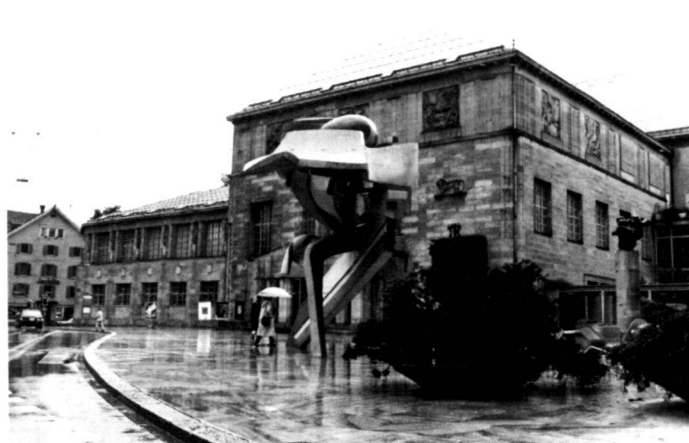
Des bacs de plantes rapidement mis en place entrent en concurrence avec l'aménagement de la place et les éléments originaux. Photos de l'auteur
