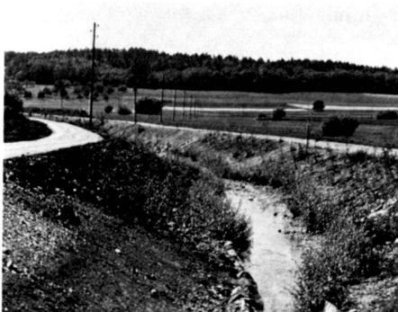
Die Bilder zeigen den Bachlauf westlich der Brücke Wilenhof mit variierender Breite der Bachsohle und ungleichmässiger Böschungsneigung. Bild 1 wurde im März, Bild 2 im Juni und Bild 3 im August 1982 aufgenommen. Die Sequenz zeigt, wie rasch die Weidenfaschinen ausgeschlagen haben und gewachsen sind und wie die Begrünung auf den nichthumusierten Böschungen dank geeigneter Ansaatmischung rasch erfolgte.
