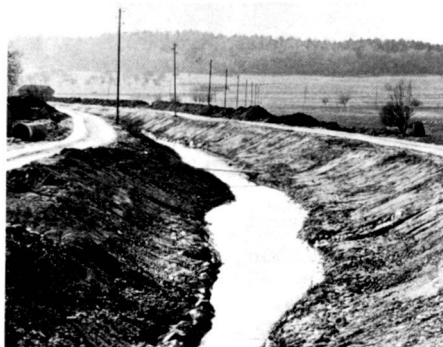
Les images présentent le cours du ruisseau à l'ouest du pont de Wilenhof, avec une largeur variable du radier et des pentes de talus inégales. La fig. 1 a été faite en mars, la 2 en juin et la 3 en août 1982. La séquence montre avec quelle rapidité les fascines d'osier ont cru et se sont développées et combien le vert est rapidement apparu sur les talus sans humus, grâce au mélange de semences approprié.
