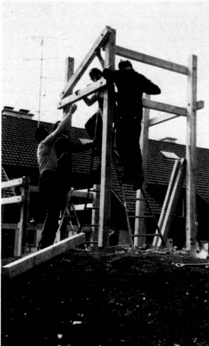
Gemeinsame Montage des Klettergerüsts.
