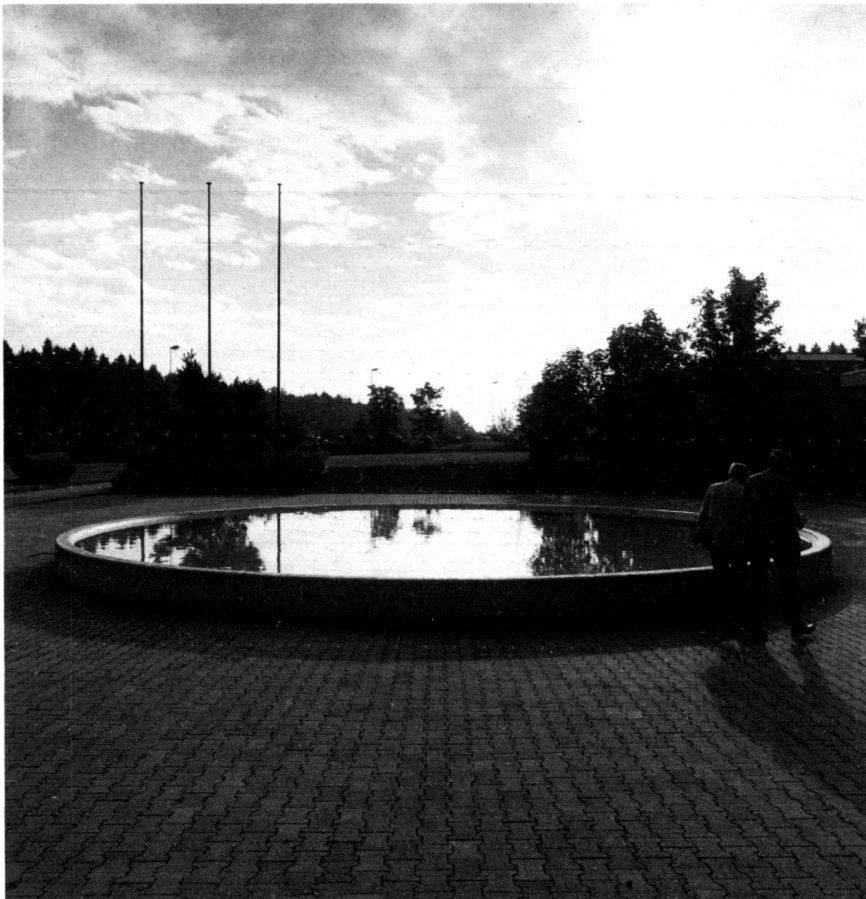
Wasserbecken beim Eingang zur Forschungsanstalt.
