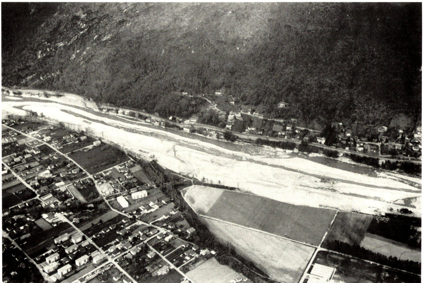
Luftaufnahme vom Maggialauf bei Losone. Im Vordergrund die Erosionsfront und das überschwemmte Landwirtschaftsgebiet.
