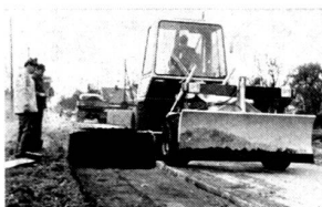
beim Bitumen-Einbau
