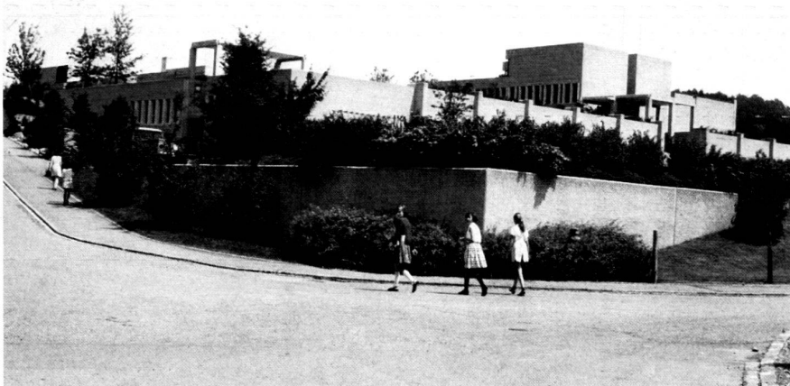
Umgrünte Turnhalle und Turnplätze des Oberstufenschulhauses «Wattbuck» vom Schulweg her.
