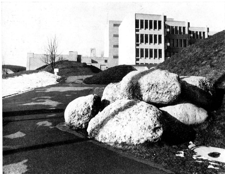
Blick durch die bewegte Geländemodellierung von Süden auf Klassentrakt und Turnhalle. Bild: Jean Haubensak, Zürich
