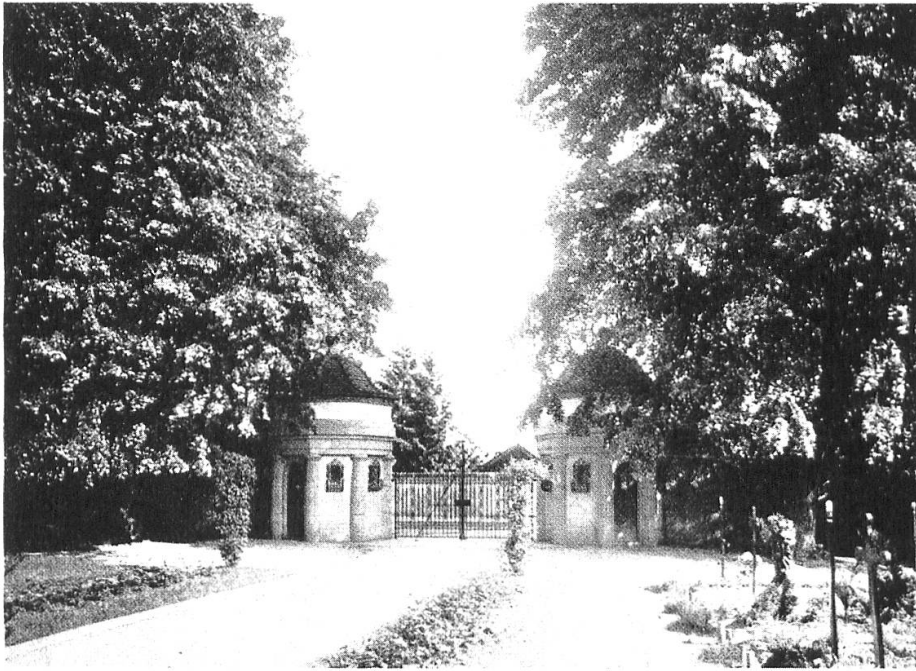
OBEN: NEUES FRIEDHOF PORTAL VON INNEN
