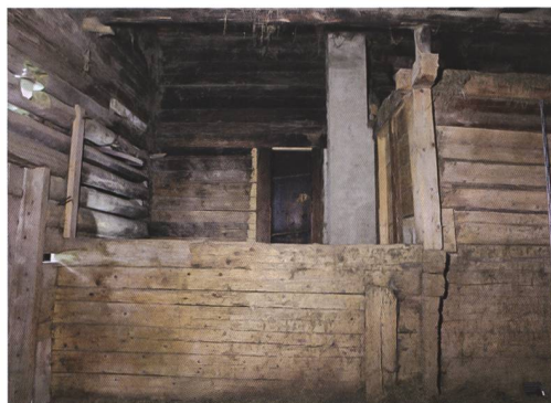
9 Kandergrund, Ausserrüti 121. Blick von der Heubühne Richtung Wohnteil. Links ist der Milchgaden zu sehen. Rechts des Gewäfts die Binnenwand zur Nebenstube. Oberhalb der Nebenstube befindet sich der kleine Gaden. Auf dem kleinen und grossen Gaden gab es weiteren Stauraum unter dem Dach. Blick nach Süden.
