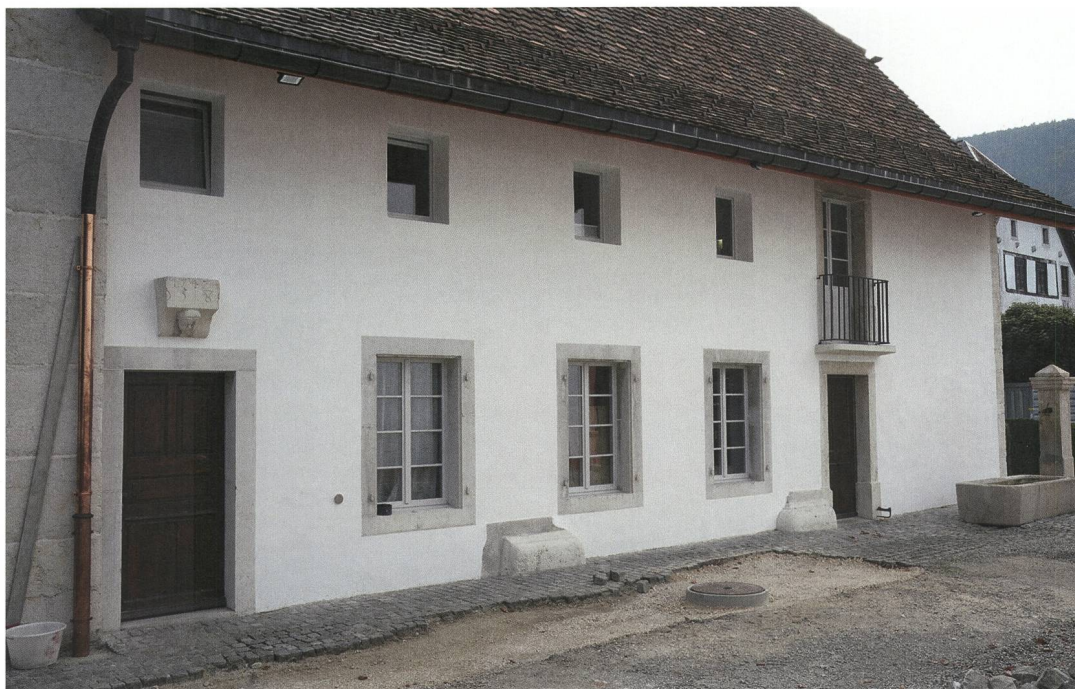
Fig. 5 : Courtelary, Rue de la Préfecture 2a/2b. La façade ouest du bâtiment étudié fut largement transformée au début du 20 e siècle. La clef de voûte à tête sculptée, en remploi au-dessus de la porte nord, et les boute-routes redressées dans le corps de maçonnerie se rapportaient à l'ancienne porte de grange vouée datée de 1580.
