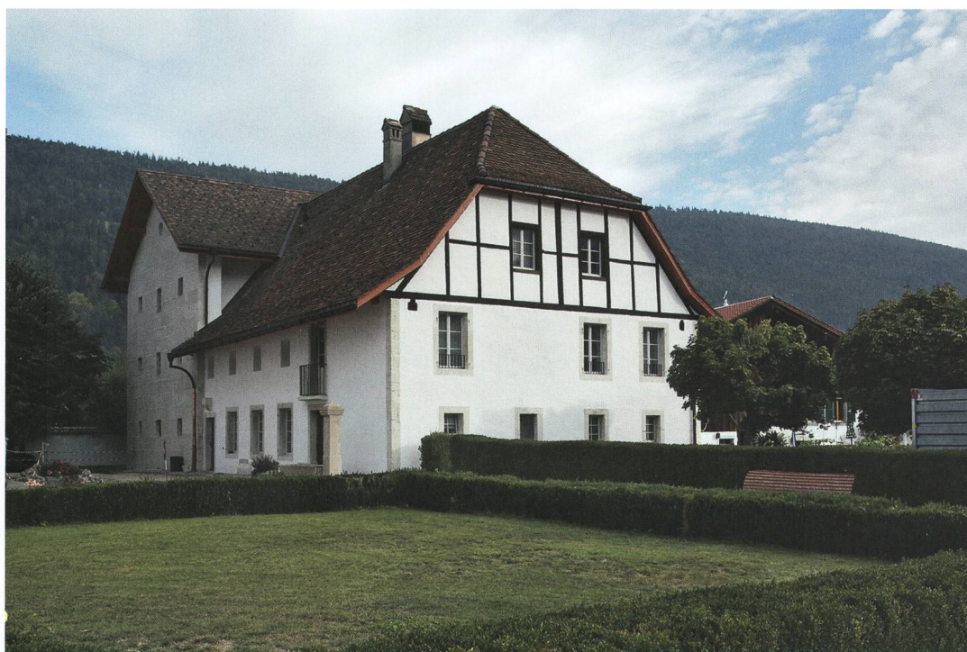
Fig. 1 : Courtelary, Rue de la Préfecture 2a/2b. Vue vers le nord de l'ancien rural et de la tour des prisons après assainissement des façades.
