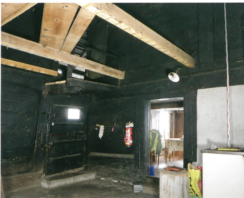
Abb. 4: Trachselwald, Vorder Giselguet 146. Rauchküche. Das Podest über der Haustüre und die Türe zur Laube sind erhalten. Die Türe in die Stube wurde nach Süden verschoben, dies geschah wohl beim Bau der neuen Mauer und der Veränderung der Herdstelle. Blick nach Südwesten.
