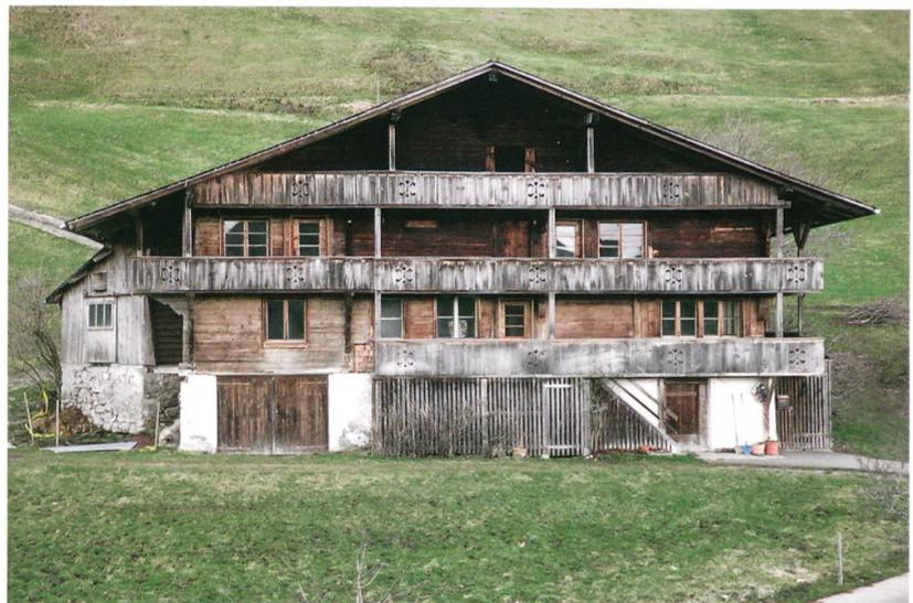
Abb. 3: Thun, Goldwil, Matthausweg 23. Die Blockkonsolen im Giebfeld sind mit zeit-typischen Einschnitten und Abfasungen verziert. Auf dem Sturzholz der Türe zur Bühnslaube befindet sich die Bauinschrift «1614 VLI RÄBER». Blick nach Süden.
