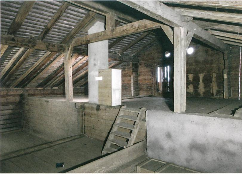
Abb. 6: Thun, Goldiwil, Matthauserweg 23. Dachraum hinter der Giebelwand mit stehender Dachstuhlkonstruktion. Links im Bild ist die Gimmwand mit der Gadenwand überkämmt. Blick nach Südwesten.
