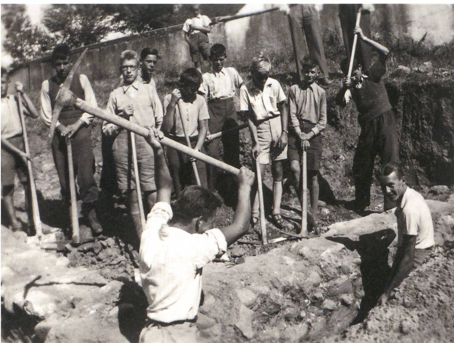
Abb. 1: Jegenstorf, Kirche 1947. Schulklasse aus Jegenstorf beim Freilegen des römischen Kellers, Blick nach Osten.
