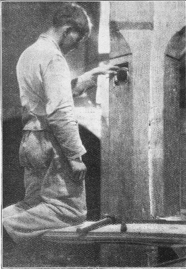
Das Mikrophon, das zur Übertragung der Orgelmusik bestimmt ist, wird in eine der hölzernen Säulen eingebaut und mit Gaze verdeckt.
