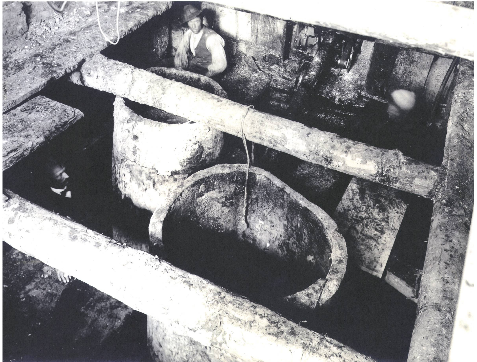
Abb. 12: St. Moritz-Bad, 1907. Aufnahme der Bergungsarbeiten mit der Röhre 2 im Vordergrund. Blick gegen Westen.
