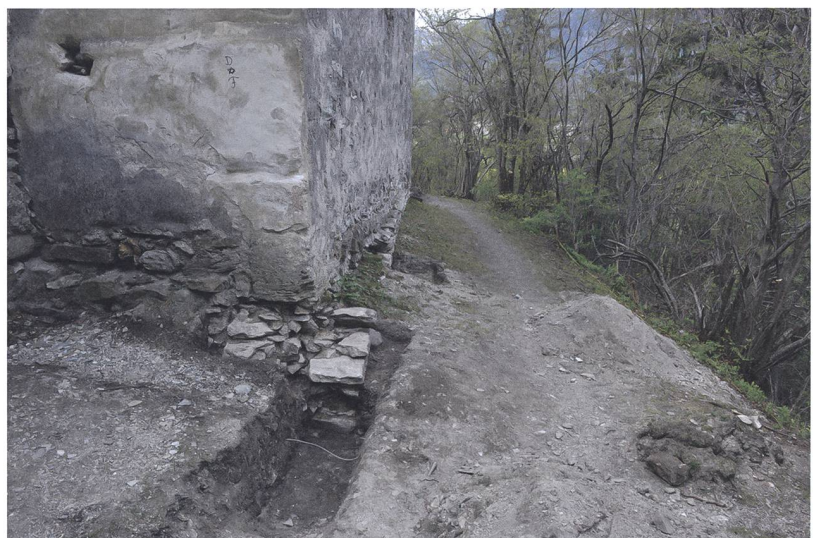
Abb. 30: Rhäzüns, Sogn Gieri. 2019. Das Fundament der östlichen Chormauer von Bau IV ragt über die aktuelle Südost-Ecke des Chores (Bau V) hinaus. Blick gegen Norden.
