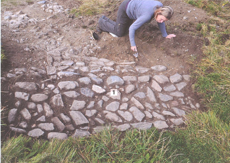
Abb. 2: Ardez, Historische Wegverbindung Ardez–Via Imperiela (IVS GR 54.1.2). 2011. Rosmarie Schütz (ADG) bei der Freilegung eines Querabschlages 1 . Im Hintergrund sind Reste unterschiedlich alter Pflasterungen zu erkennen. Blick gegen Südwesten.
