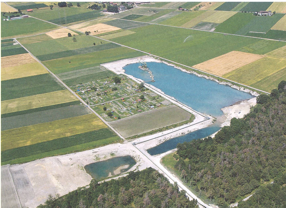
Abb. 1: Untervaz, Kiesgrube. 2012. Der Baggersee, aus dem die Lanzenspitze und das Beil aus Bronze gehoben wurden. Blick gegen Norden.
