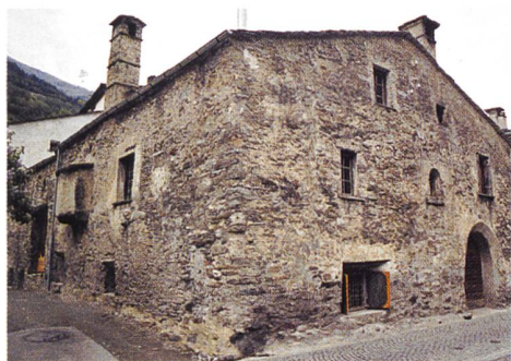
Fig. 116: Poschiavo, Borgo, Casa Tomé. Situazione dopo il restauro. Vista verso sud-est.
