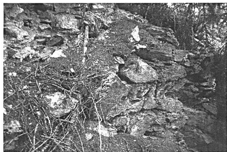
Abb. 4: Müstair, Burgruine Balcun At. Lagiger Mauerrest des «Turms» über der Steilwand zum Val Brüna.
