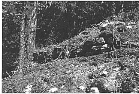
Abb. 5: Müstair, Balcun At. Letzte Steinlagen der Nordwestecke der westlichen Burgmauer, August 2000, vor der Bestandessicherung.
