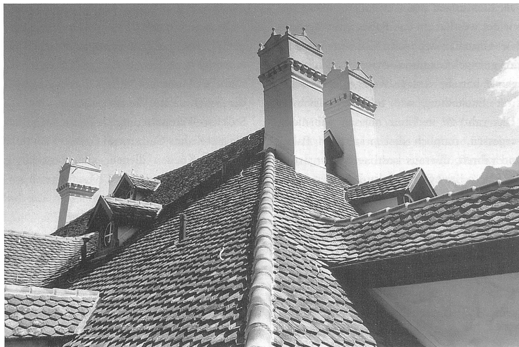
Abb. 126: Chur, Altes Gebäu. Reich gestaltete Aufbauten und Kamine auf dem Walmdach (Südostecke).
