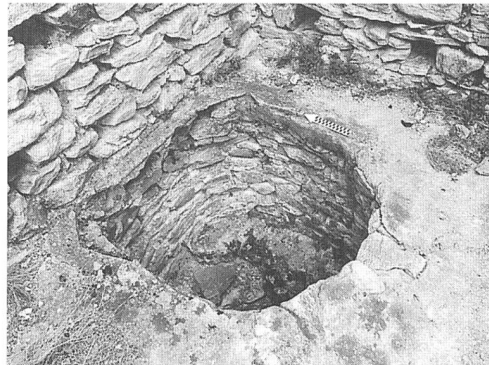
Abb. 57: Die Tankzisterne in der NW-Ecke der Plattform im 6. Geschoss.
