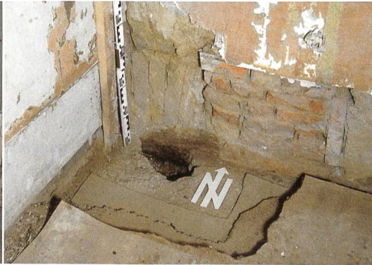
Allschwil, Schönenbuchstrasse 17, interne Wand im Erdgeschoss. Füllung unter anderem aus ungebrannten Lehmziegeln. Datierung 18. Jahrhundert.
