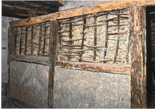
Oberwil, Kirchgasse 5 (Sigristenhaus), Trennwand im ersten Dachgeschoss, Untersuchung von 1997. Dendrochronologisch nicht datierbar, 1634 oder 1770er Jahre.
