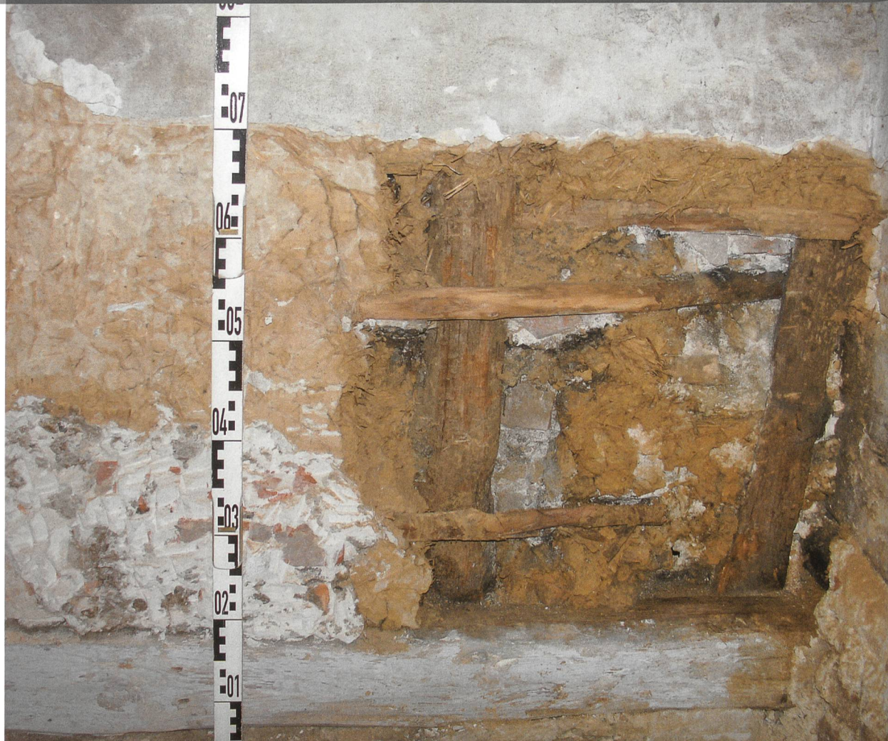
Binningen, Schlüsselgasse 4, interne Wand, nach- träglich eingebaut als Trennwand zwischen Schmiedestube und Kammer. Datierung 17. Jahrhundert.
