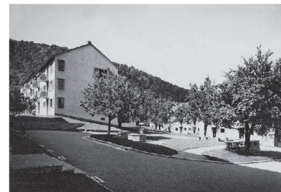
^ 1_ Die abgebrochene Siedlung Triemli in Zürich-Albisrieden.
