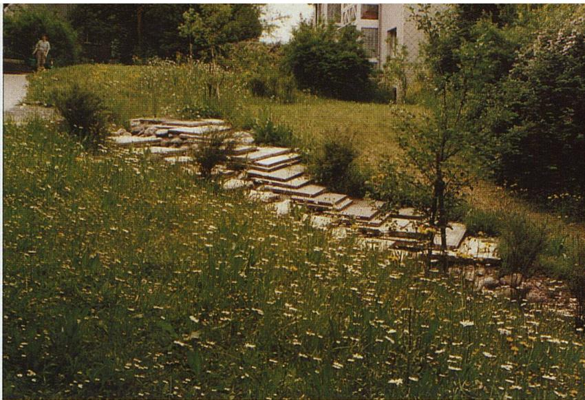
Beim aufgedeckten Bach wurden ausrangierte Betonelemente zur Neugestaltung eingesetzt.
