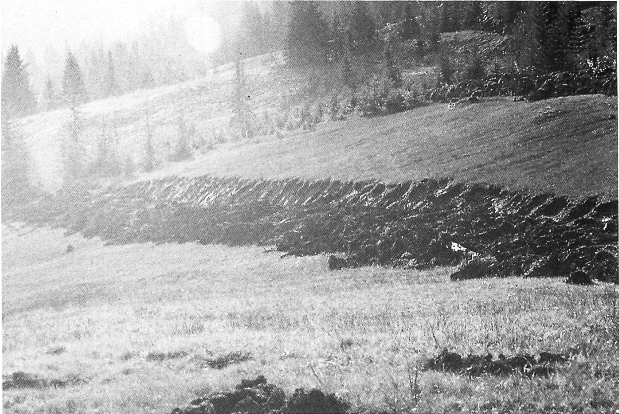
Abbildung 8. Bild einer im Bau befindlichen Waldstrasse im Kanton Luzern. Das Trasse der Strasse verläuft mitten durch ein grossflächiges Hangmoor. Foto: A. Grünig.
