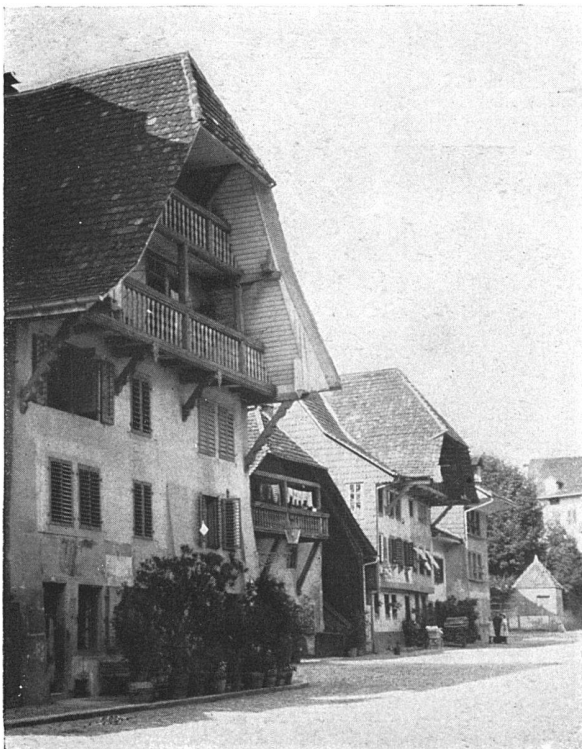
Das Haus „zum großen Mohren“ in Zofingen
