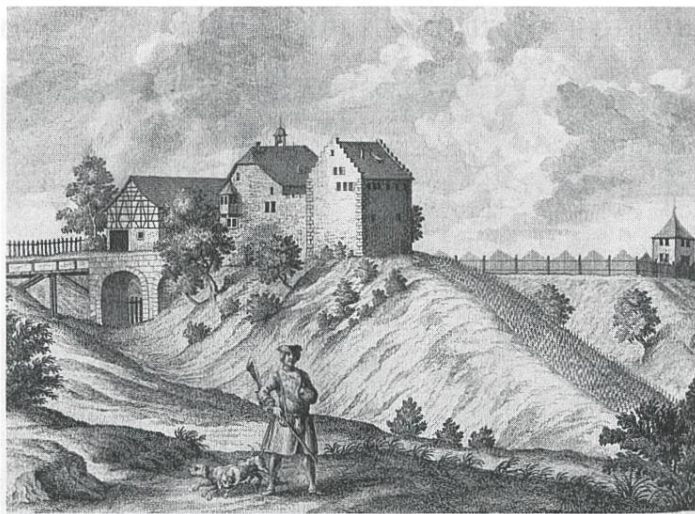
Abb. 33: Obervogtei Schloss Wellenberg bei Wellhausen TG.
