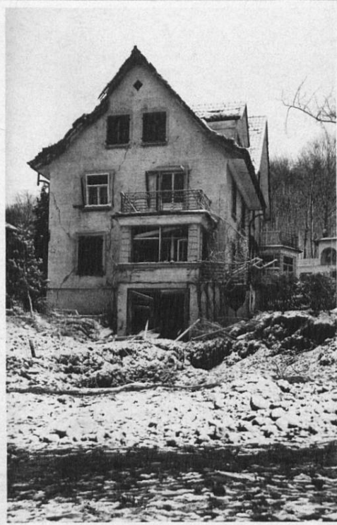
Frohburgstrasse Nr. 174, Assek. Nr. 1336, (Haus Prof. Tank.)
