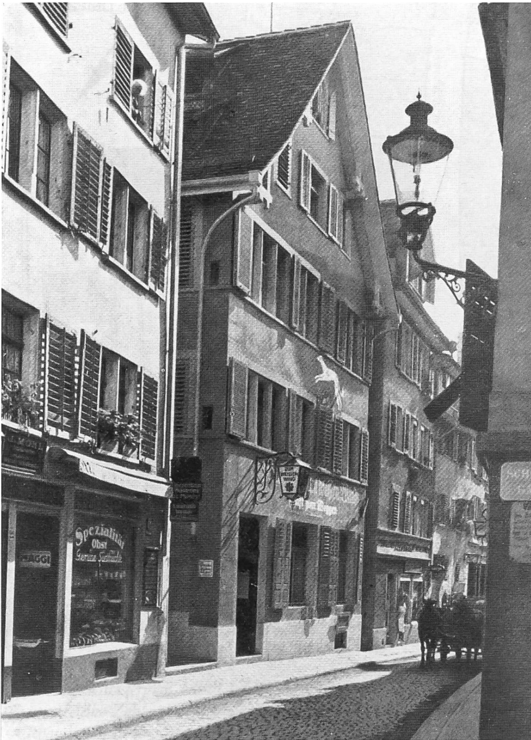
Abb. 9: Oberdorfstrasse beim «Weissen Wind» 1928 Foto: A. Ryffel, Repro BAZ (vergl. Anm. 13)
