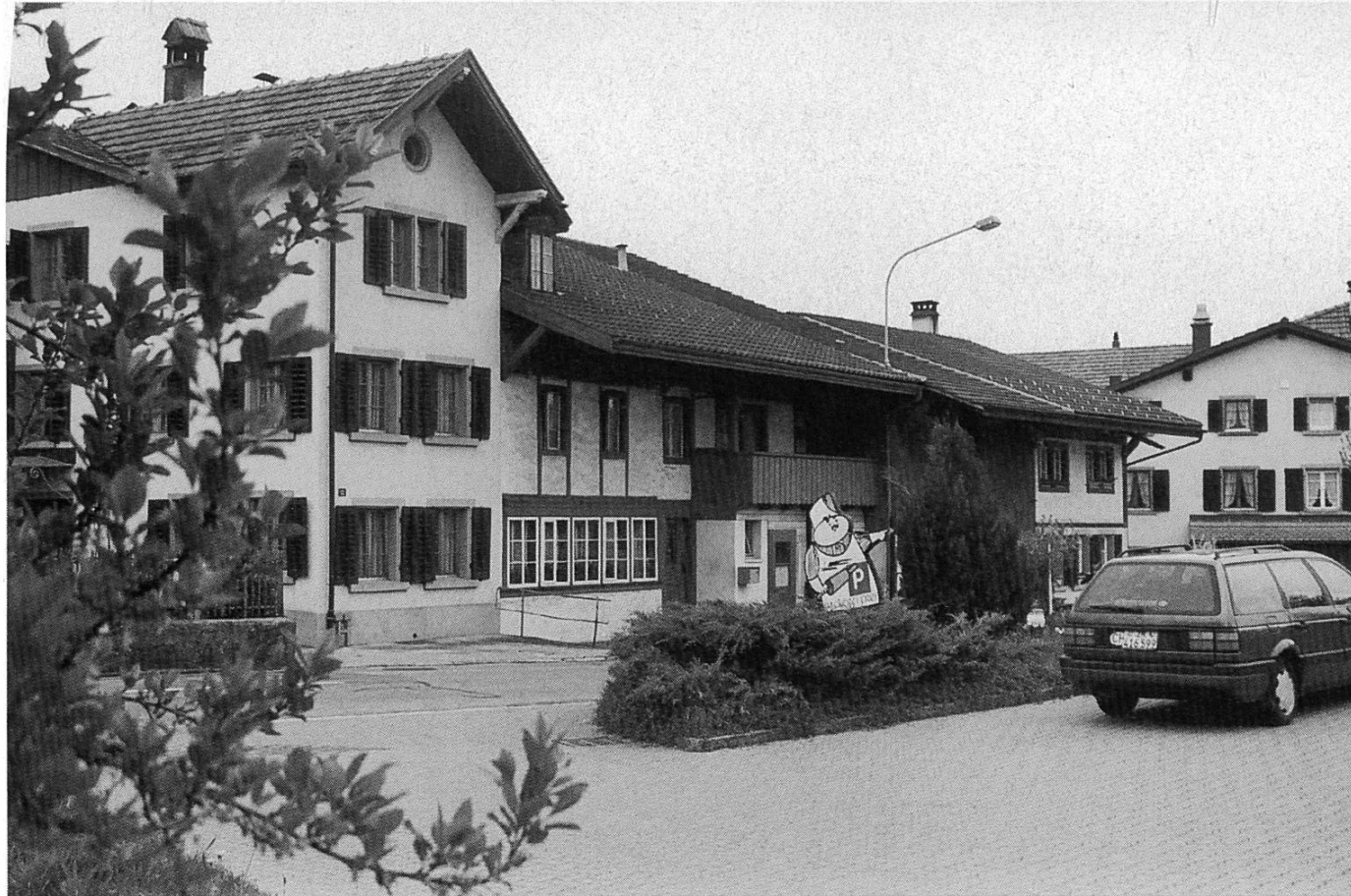
Letzte Station in Rüeggs Leben, hier starb er im Februar 1873, im mittleren Flarzteil an der Illnauerstrasse 10 in Weisslingen (Aufnahme von Erich Peter)
