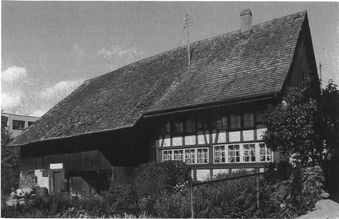
Abbildung 2: Haus Utikonerstrasse 27: Westfassade und südlicher Giebel.
