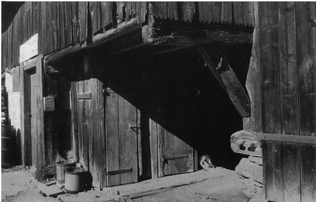
Abbildung 7: Hölzernes Abtrittshäuschen in der Scheune neben dem Stall.
