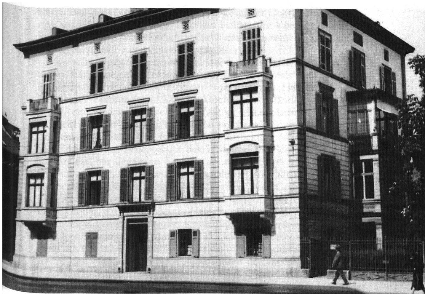
Ansicht des Goedecke-Hauses, Seefeldstrasse 9, Zürich
