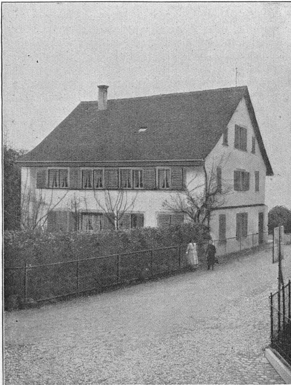
Die 1636 vom Staate erbaute Helferei.
