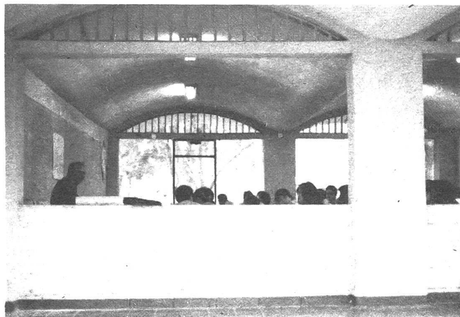
Vorlesungssaal: offene Seitenwände – Kühlung
