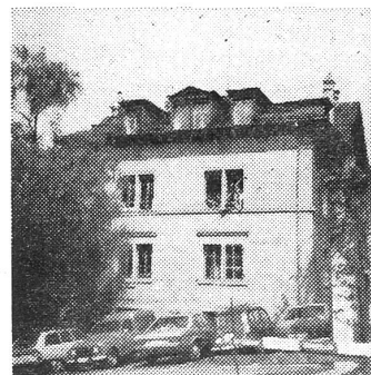
soll abgebrochen werden.
