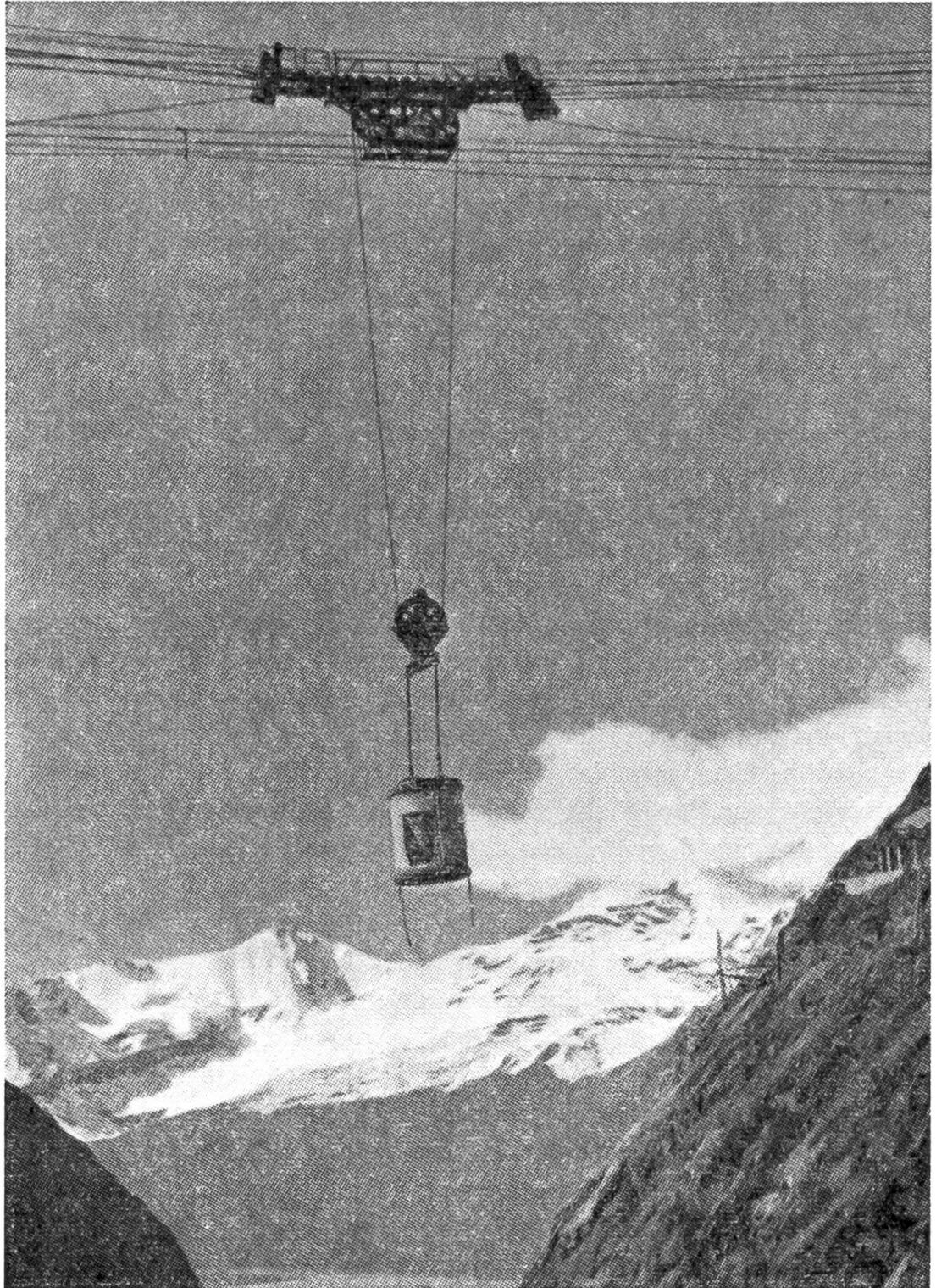
Kabelkrane verteilen den Beton auf der ganzen Baustelle.
